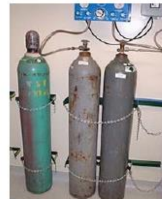
รูปที่ 2.2 ตัวอย่างการวางถังแก๊สที่เหมาะสมในห้องปฏิบัติการ (ที่มา เข้าถึงได้จาก http://blink.ucsd.edu/safety/research-lab/chemical/gas/storage.html#Basic-storage-guidelines-for-al สืบค้นเมื่อวันที่ 2 สิงหาคม 2556)
