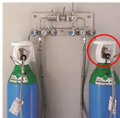
รูปที่ 2.3 ตัวอย่างถังแก๊สที่มี guard ป้องกันหัวถัง ขณะใช้งาน (ที่มา เข้าถึงได้จาก http://proactivegasafety.com/gas-safety-training-workshops/laboratory-gas-users-workshop สืบค้นเมื่อวันที่ 27 กรกฎาคม 2556)
